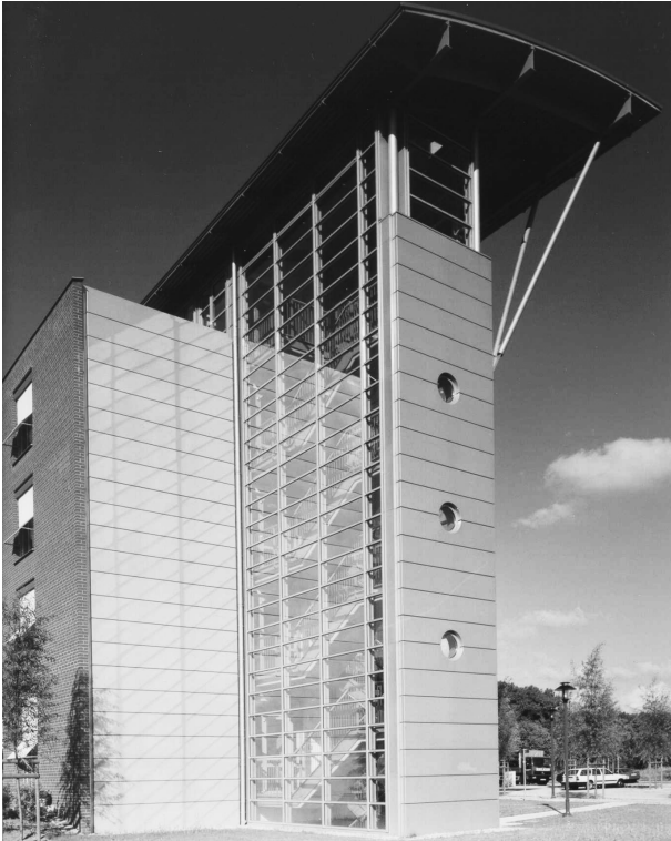
Dekoratив und funktional: Kombination von silbern schimmernden Aluminium-Fassaden- verkleidungen und Fensterprofilen am Arbeitsamt Bremerhaven
